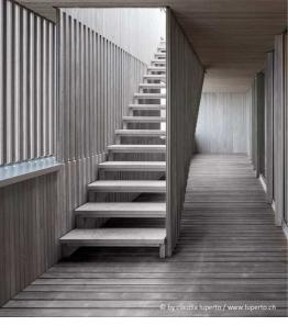
Der Holzbau wurde in Holzrahmenbauweise mit sichtbarer Holzbalkendecke ausgeführt, die vorvergraute Fassade aus Weisstanne als schmale Vertikalschalung realisiert. Bei den Öffnungen im Norden und Süden wurde die Fassade fortgeführt und jede zweite Holzlattung ausgeklinkt, sodass eine Abgrenzung zur Nachbarschaft erzeugt wird.
