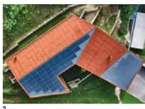
Die zwei PV-Anlagen decken mit einer Produktion von 17'500 kWh/a 155% der Eigenenergie-
